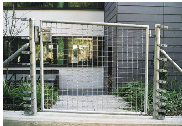
Rohrtüre in Steigung
