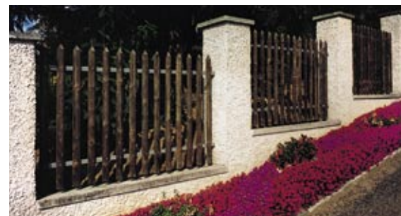
Palisadenzaun mit Metalltraversen
